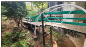
松下館の橋 修繕
