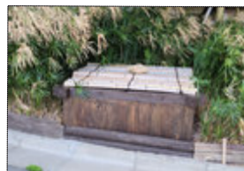
マンホール隠し
