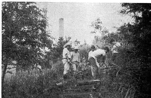
職員にまじって道路の補修工事を手伝う学生もいる
