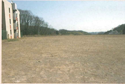
完成した多目的グラウンド
